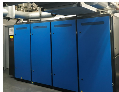
Bild 3: Das Loganova BHKW EN140 von Buderus ermöglicht eine Leistungsabgabe von bis zu 140 kW
